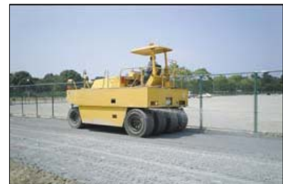
路盤施工状況
