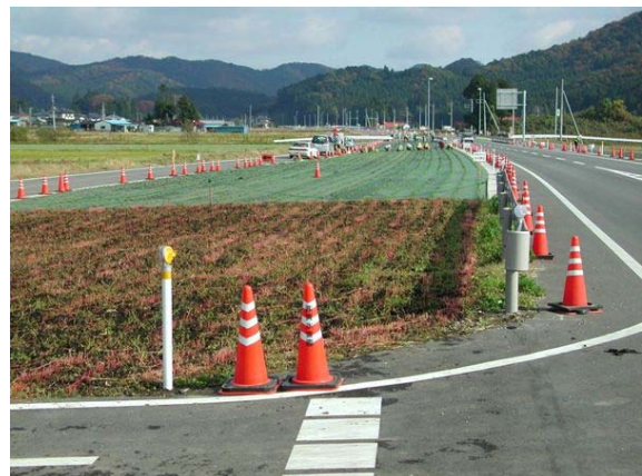
植樹ニューマットC施工例
