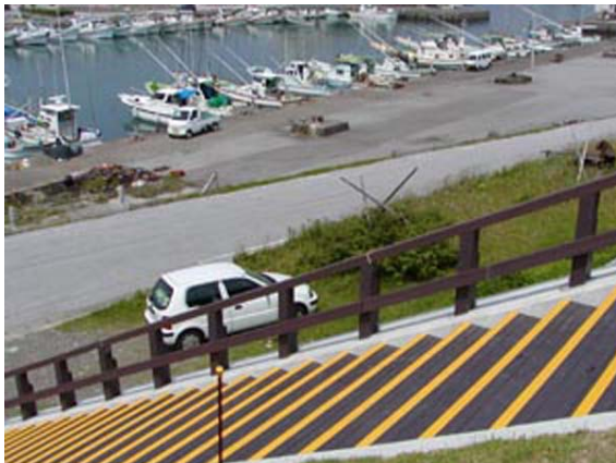
階段・手摺り柵
