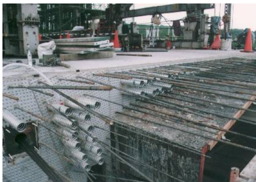
打ち継ぎ目の施工状況
