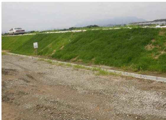
施工後8週間の状況
