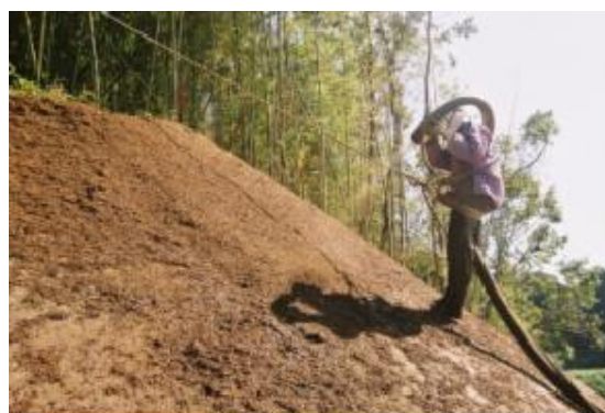
施工状況写真
