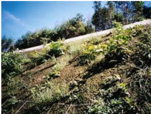
施工後4ヶ月(9月)の状況
