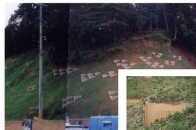
生分解性法面植栽枠設置直後
