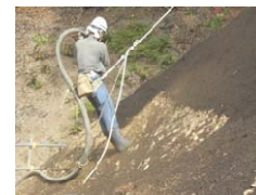
吹付植生基盤への混合
