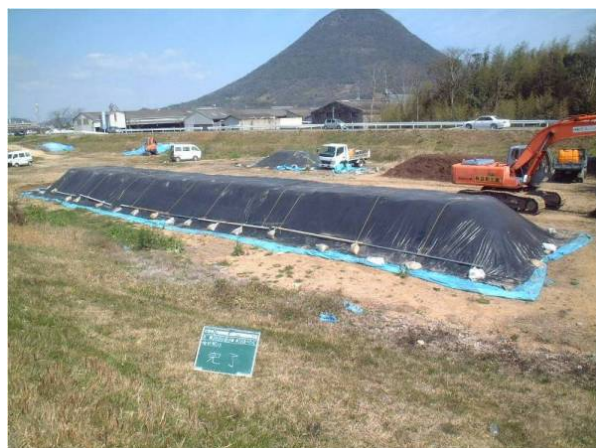
熟成状況(簡易シート工法)
