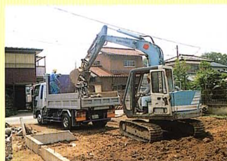
④ 基礎及び外構の取り壊し
