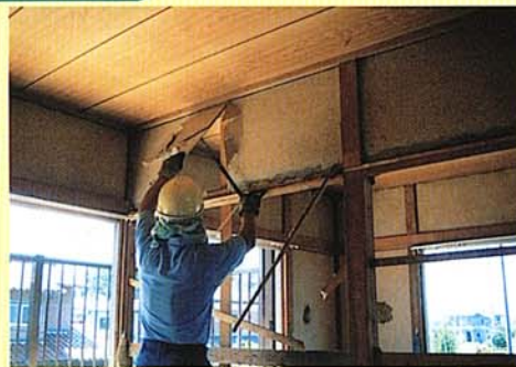
① 建築設備・内装材等の取り外し
