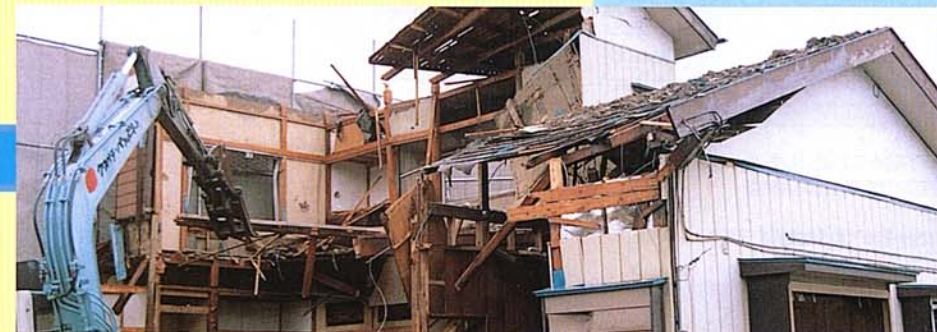
注) ③ 外装材・上部構造部分の取り壊し
