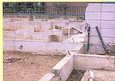
④ 基礎及び外構の取り壊し
