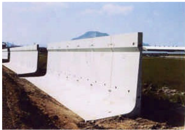
L型擁壁設置完了
