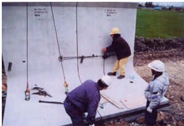
つり込み後ジャッキによる設置状況
