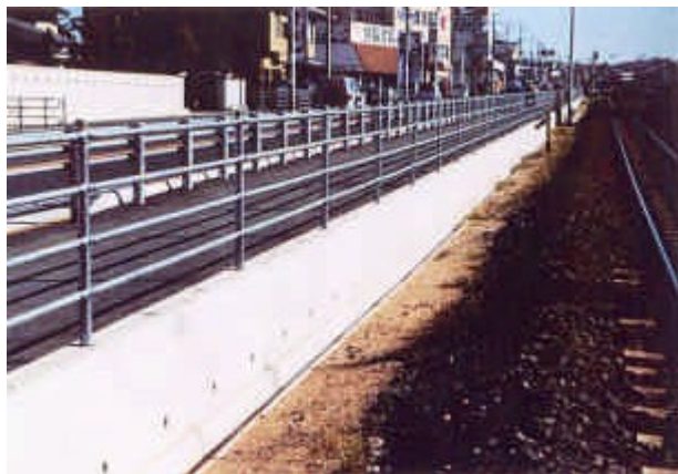
L型擁壁完成状況
