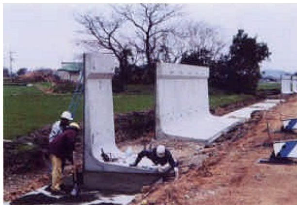
モルタルによる高さ調節
