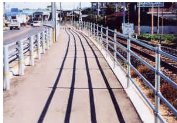
曲線部の施工状況
