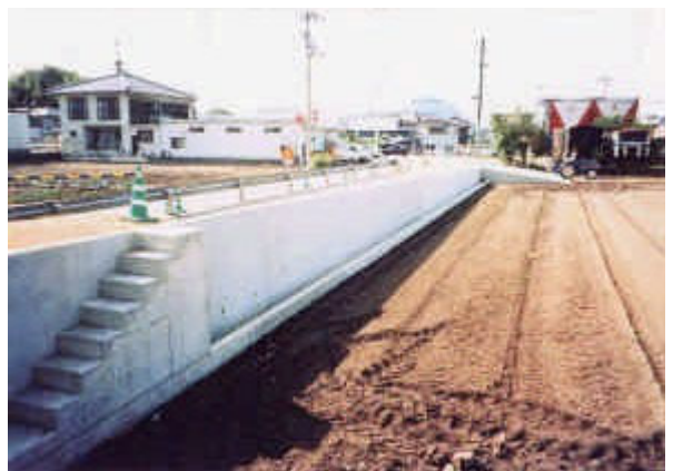
縦断勾配の付いた施工状況
