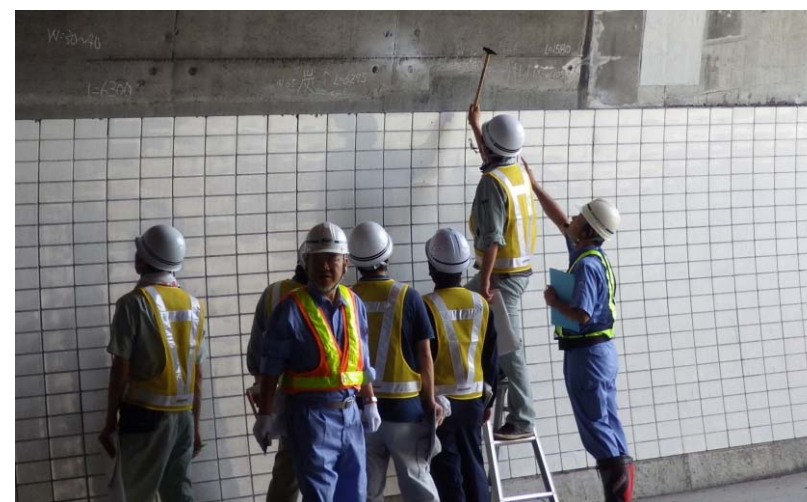
現地実習状況（H28トンネル初級）
