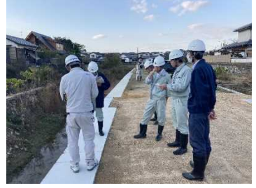
県工事への臨場 実施状況
