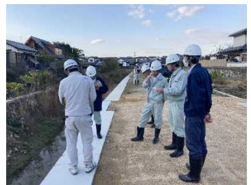
県工事への臨場 実施状況
