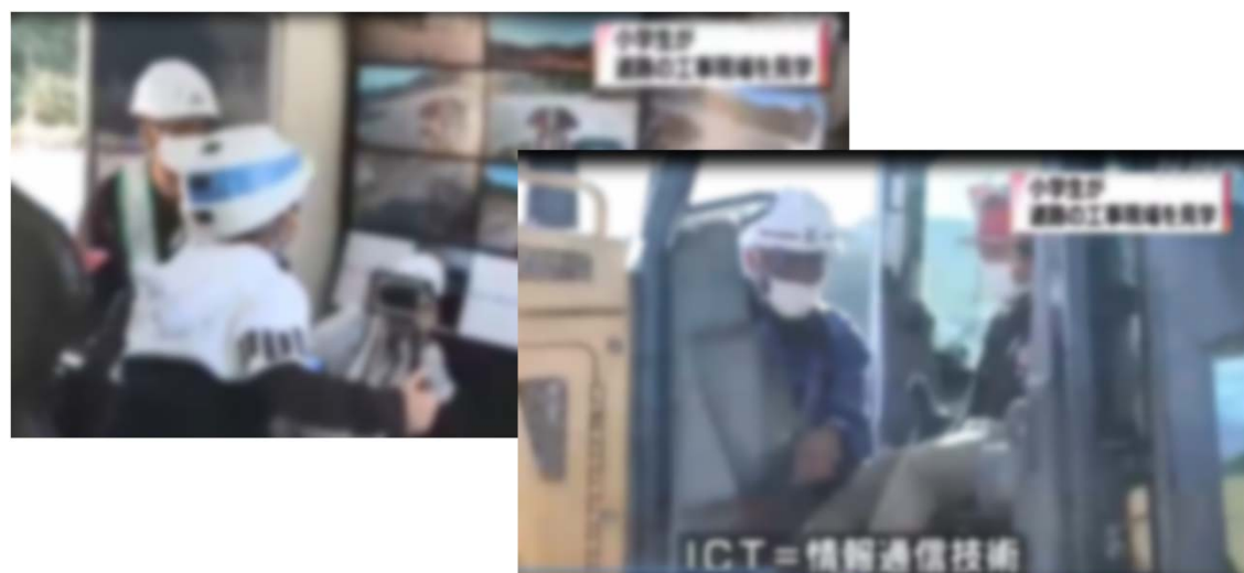
「小学生たちが道路の工事現場を見学 黒潮町」 令和4年10月20日(木) NHKニュース (NHK高知放送局)
