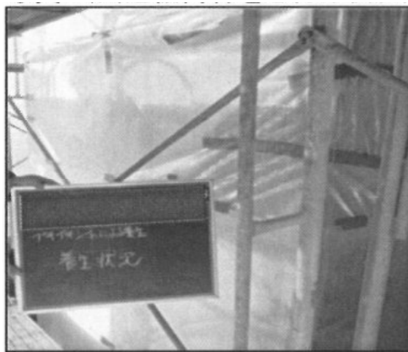
写真 3.1 気泡緩衝材を用いた養生
