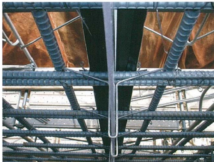
図 3.3 誘発目地取付け図
