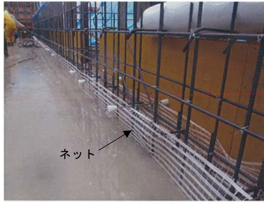
写真 5.1 ひび割れ抑制用ネットの施工例
