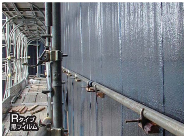
写真 2.2 側壁にも使用可能な養生マット（コンクリート表面の乾燥抑制）
