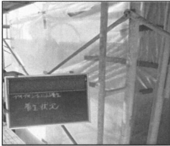
写真 4.2 気泡緩衝材を用いた養生
