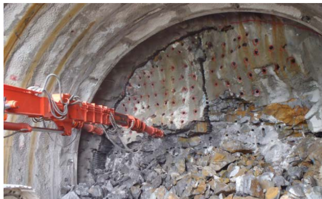
写真2 割岩工法(FON工法:破砕状況)
