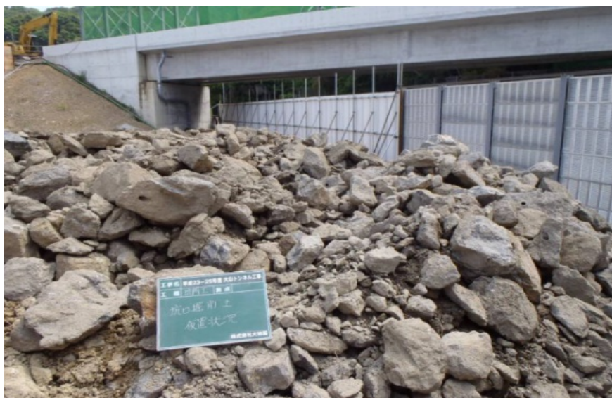
写真1 現地発生土(大きな岩塊の集まり)
