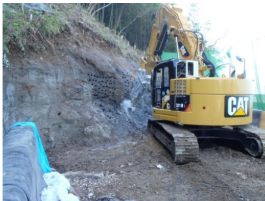
写真1 ブレーカ掘削状況
