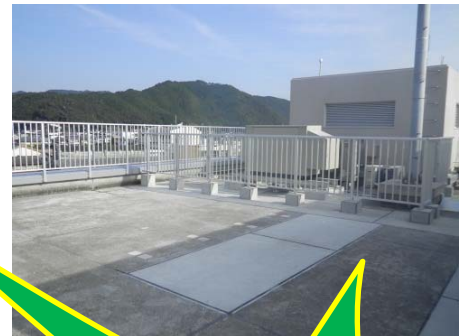
外の避難階段から屋上に一時避難！
