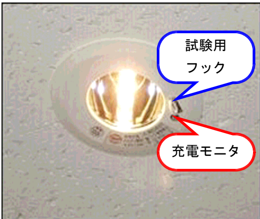
【非常用照明器具(電池内蔵型)】
