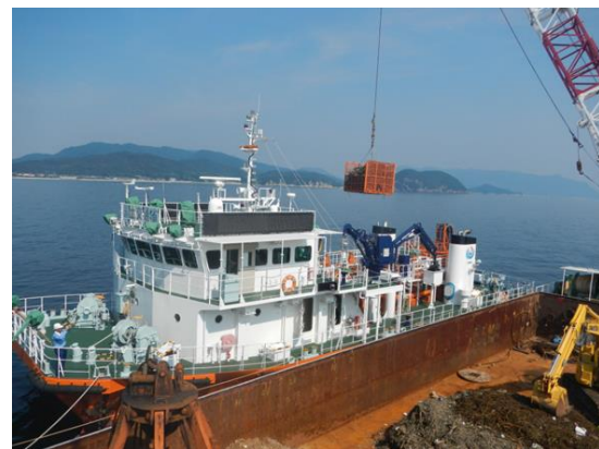
起重機船との連携状況「美讃」(7月18日)
