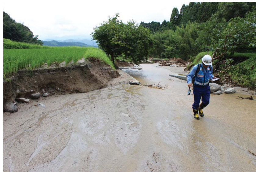
田んぼの崩壊状況
