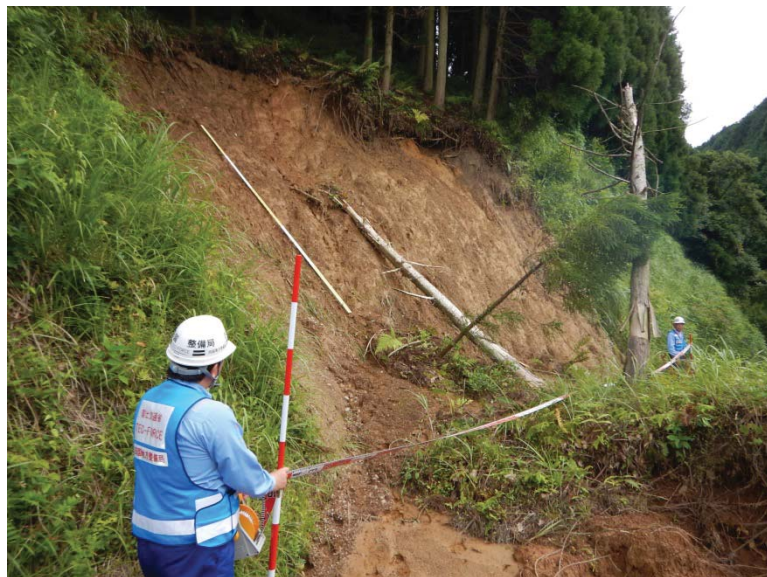
土砂災害による道路閉塞状況
