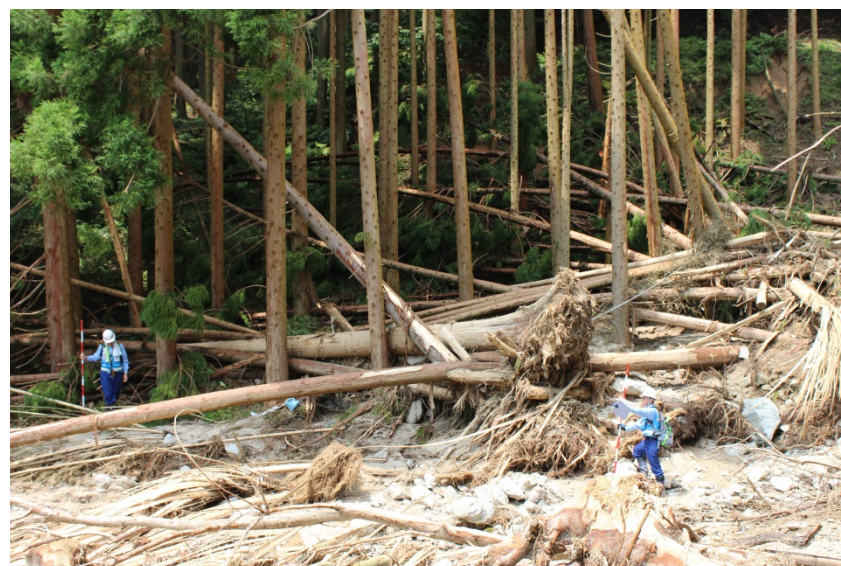
土砂による倒木状況（砂防班）
