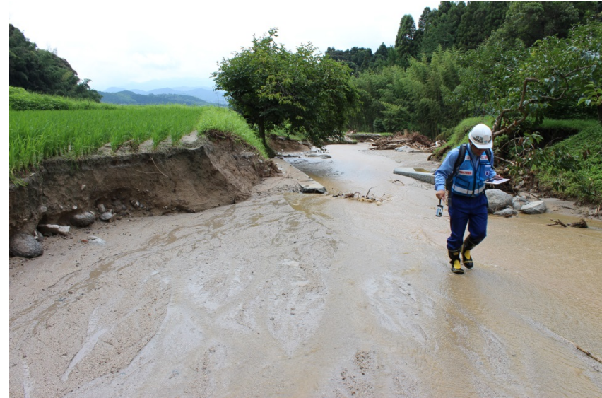
田んぼの崩壊状況
