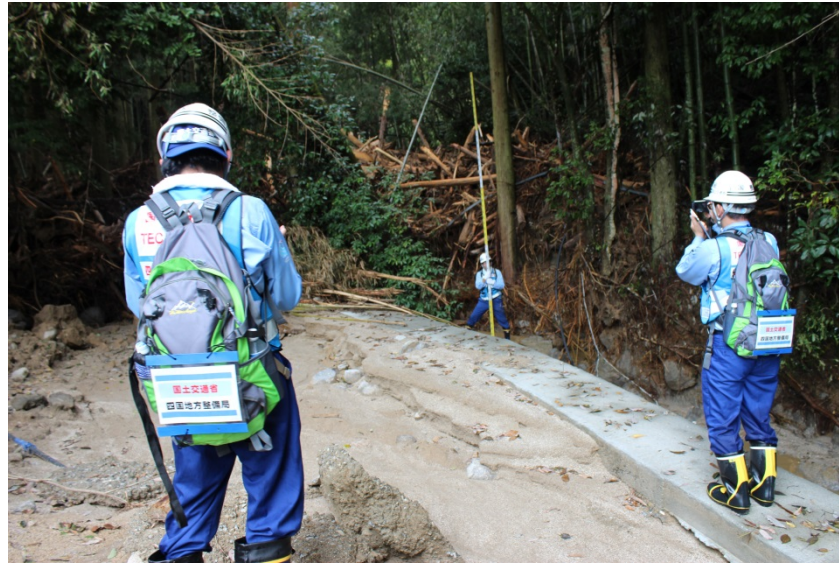
流木による川の閉塞状況
