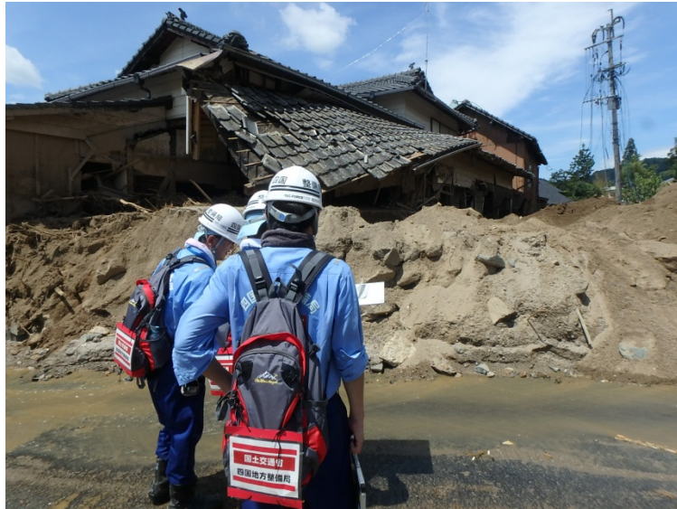
道路・家屋の被害状況調査
