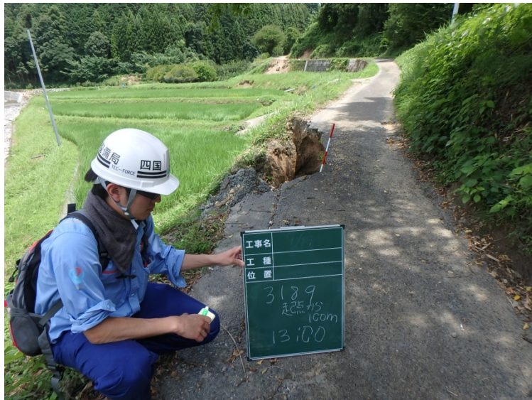
道路の陥没状況調査
