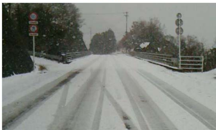
周囲の路面状況
