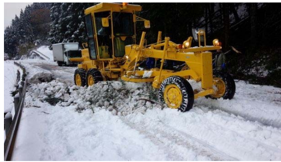
国道32号 徳島県三好市池田町西山付近
