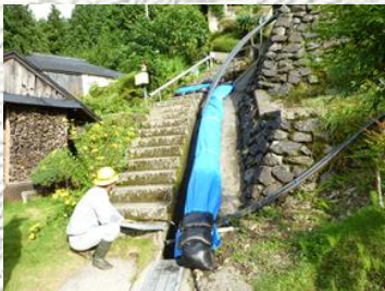
水路補修(完了)
