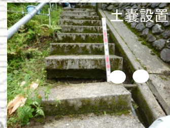
浸透防止対策 水路補修(土嚢設置)
