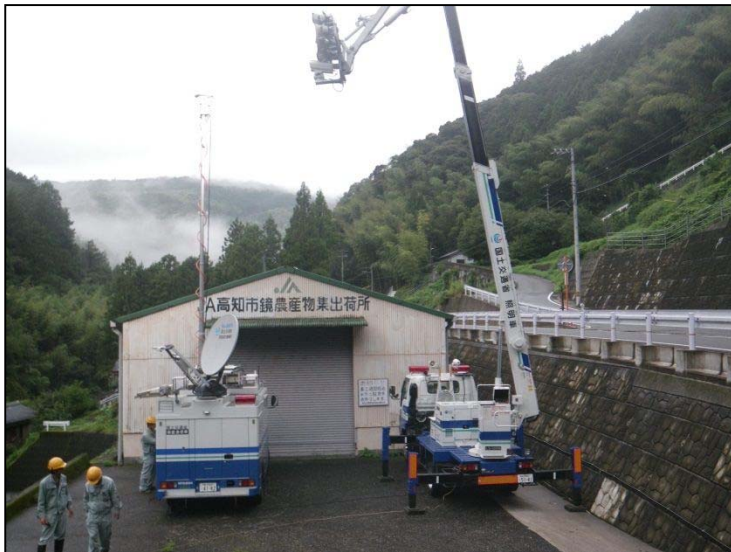
照明車と衛星通信車の設営状況
