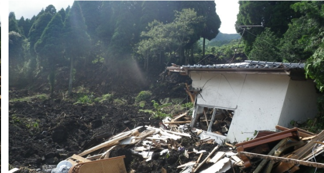
土砂災害被災状況視察
