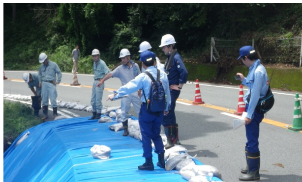
道路法面崩壊箇所応急復旧方法の技術的支援実施
