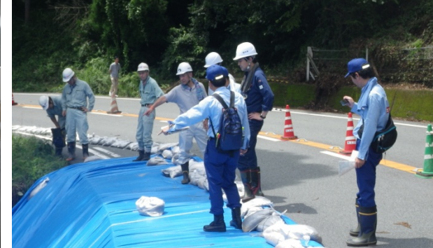
道路路面崩壊箇所応急復旧方法の技術的支援実施
