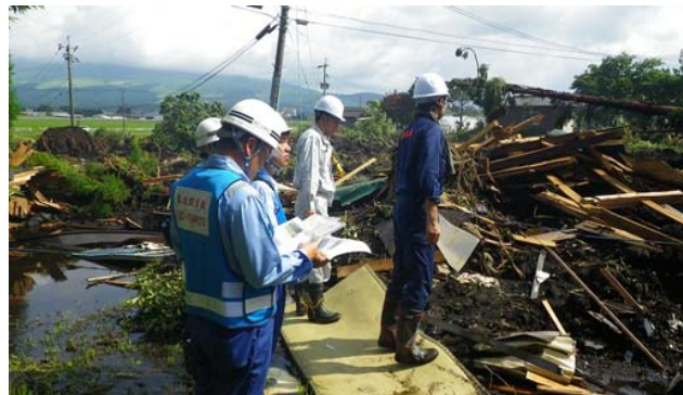
土砂災害被災状況視察
