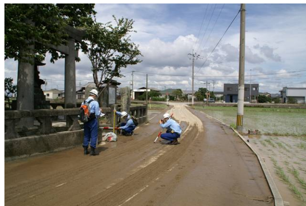
浸水痕跡の現地踏査状況
