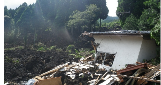
土砂災害被災状況視察
