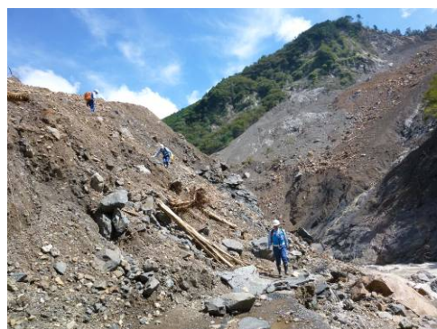
一次的に河道閉塞した箇所のケーブル確認
