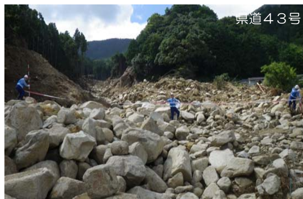
土石流による橋梁・道路流出 (L≒50m)
