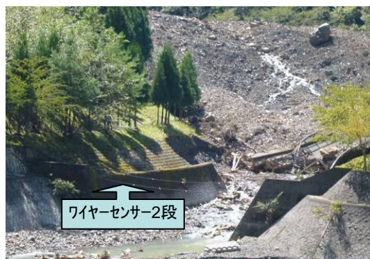
18日調査時、ワイヤセンサー赤谷出口に設置
