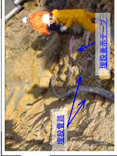
光ケーブル埋設管路 崩壊状況
