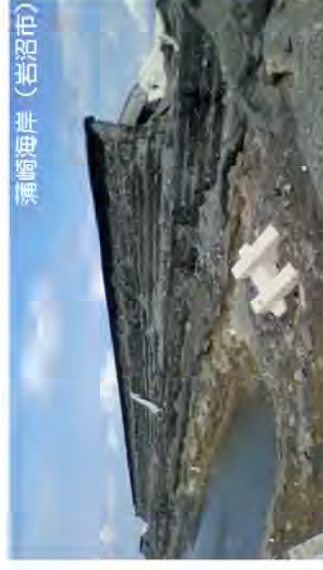
海岸堤防の津波による裏法面の洗掘状況
