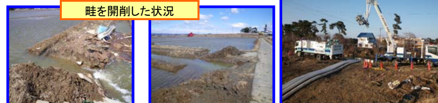
排水路等が閉塞しているため畦等を開削して湛水箇所の排水を実施
