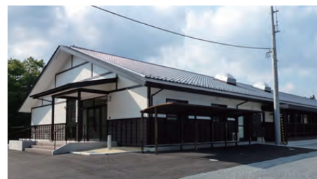
「井戸端長屋」馬場野 1 号棟 平成 24 年 5 月 2 日完成
