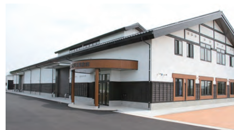
「防災備蓄倉庫」 平成 25 年 8 月 25 日完成
