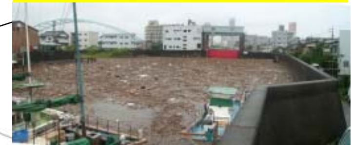
漂着したゴミ及び木材等により、泊地が埋塞した。(写真は若松町地区)
