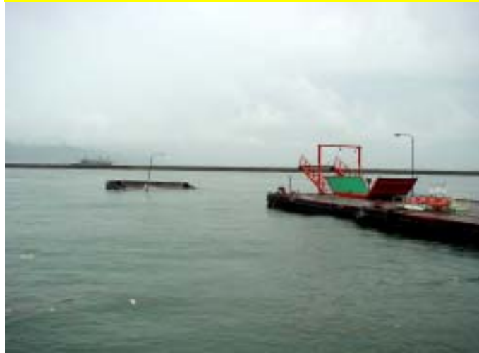
波浪・高潮の影響で、浮棧橋1基が沈没。
