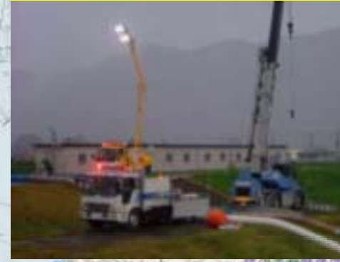
照明車(吉野川支川ほたる川)
