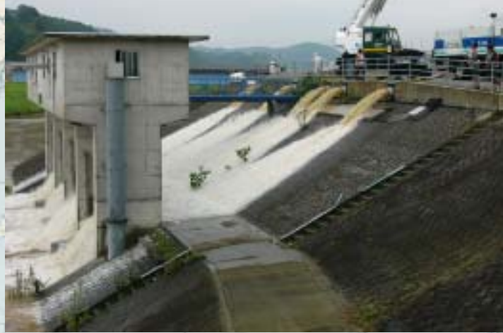
排水ポンプ車150m 3 /min 矢落川支川都谷川 (内水排除)
