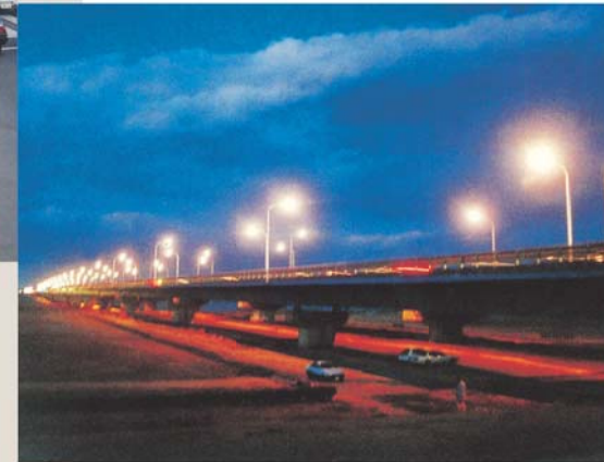
安全な走行をサポートする道路照明
