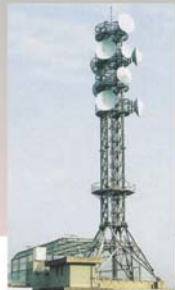
多重無線回線通信塔
