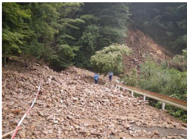
〔道路班の被災調査〕
