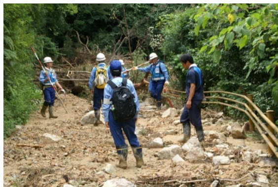
〔道路班 市道中津坂線の被災調査〕
