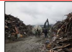
【道路啓開状況】
