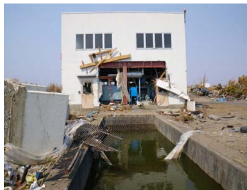
雨水排水ポンプ場の現地調査
