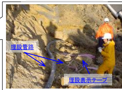
光ケーブル埋設管路 崩壊状況
