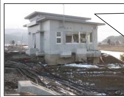
月浜第一水門局舎
