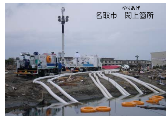
排水ポンプ車により津波で 貯まった水を川や海に排水
