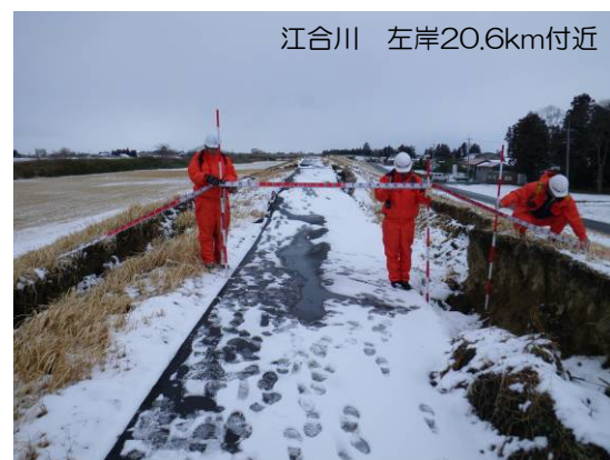
雪の中での調査（堤防の沈下）
