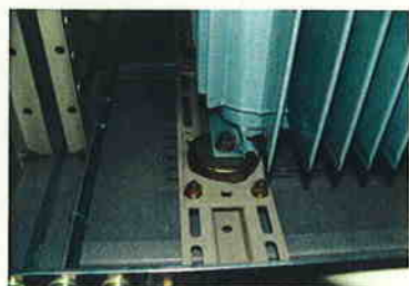
① 変圧器固定
