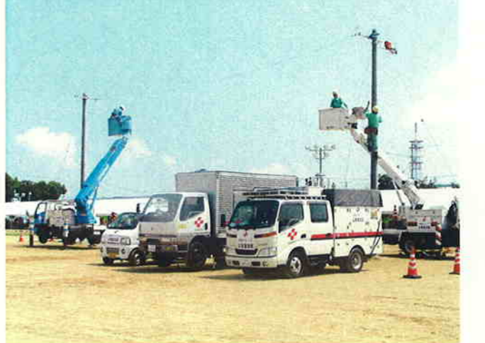
【災害復旧訓練】 (資料提供：四国電力)
