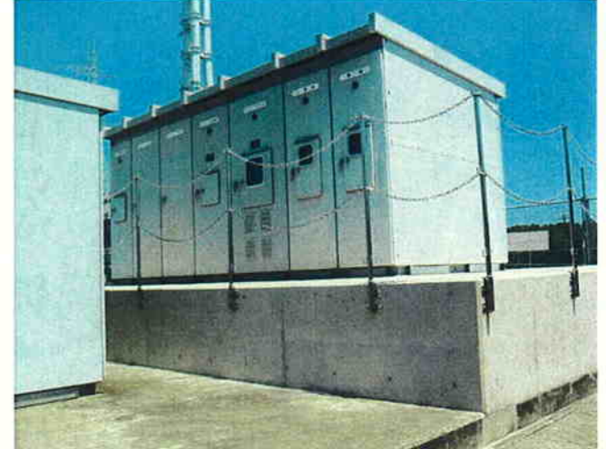
【変電所設備の一部かさ上げ】
